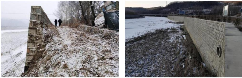
图 2-2 干流左右岸浆砌石防洪墙
